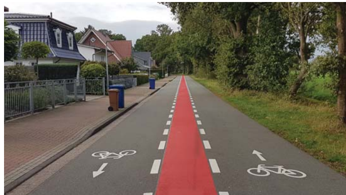
Die neue Fahrradstraße zwischen Bad Zwischenahn und Oldenburg innerorts mit Piktogrammen und rotem Mittelstreifen / Foto: ADFC Ammerland
