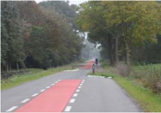
Der Baumbestand entlang der Trasse konnte weitgehend erhalten bleiben. Einengungen sorgen zusätzlich für Verkehrsberuhigung / Foto: ADFC Oldenburg
