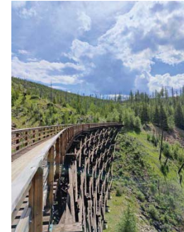
Fachwerkbrücke am Myra Canyon
