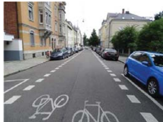
Bild 2: Beispiel für eine Fahrradstraße im Streckenverlauf mit Piktogrammen und Sicherheitstreifen (Quelle: Fahrradstraßen - Leitfaden für die Praxis , Bergische Universität Wuppertal/Deutsches Institut für Urbanistik (Hrsg.), Wuppertal/Berlin, 2021)
