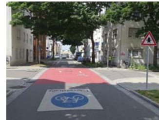
Bild 3: Beispiel für eine Fahrradstraße im Kreuzungsbereich mit Markierung und Piktogrammen (Quelle: Fahrradstraßen - Leitfaden für die Praxis , Bergische Universität Wuppertal/Deutsches Institut für Urbanistik (Hrsg.), Wuppertal/Berlin, 2021)
