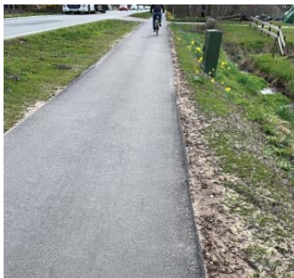
Saniertes Radweg Elsfl ether Land / Foto: Frauke Sterwerf
