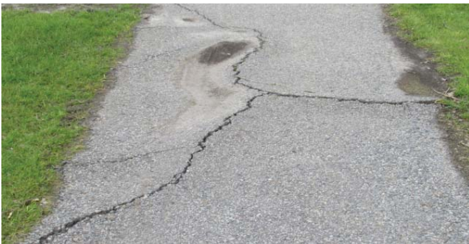
Schadensbild / Foto: NLSTBV Niedersachsen
